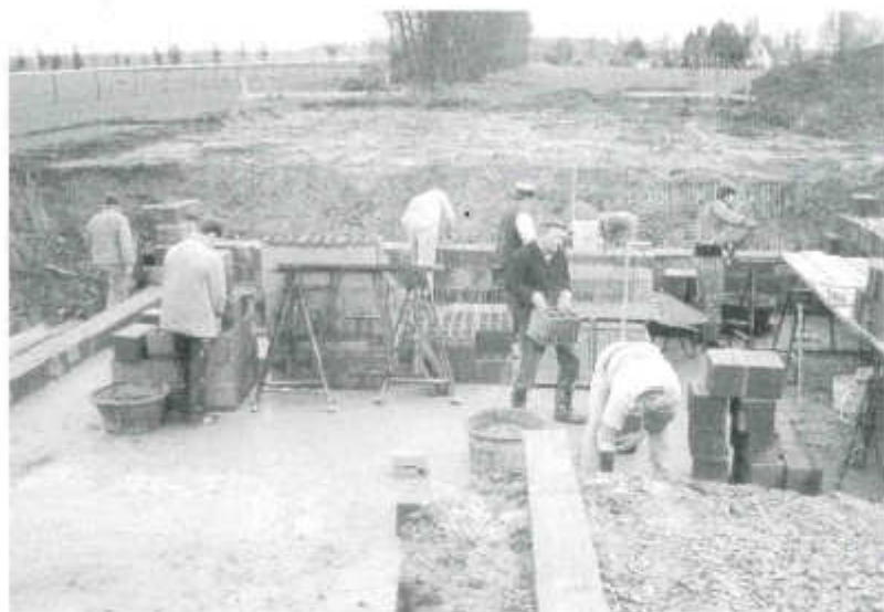
Bilder 55/56: Der Bau des neuen Sportheims
